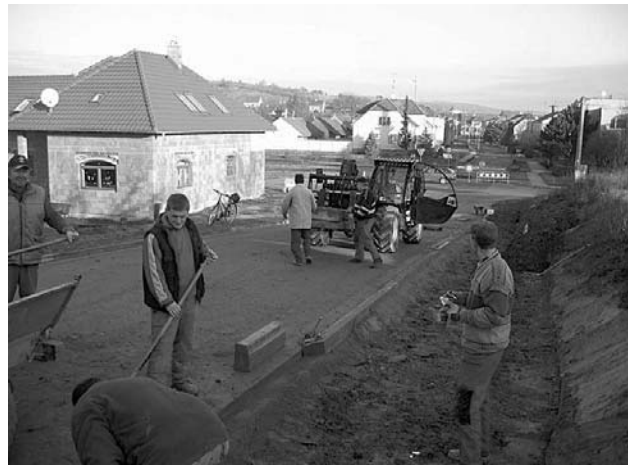
Pracovníci služeb města usazují obrubníky před novými bytovkami na Padělkách.
